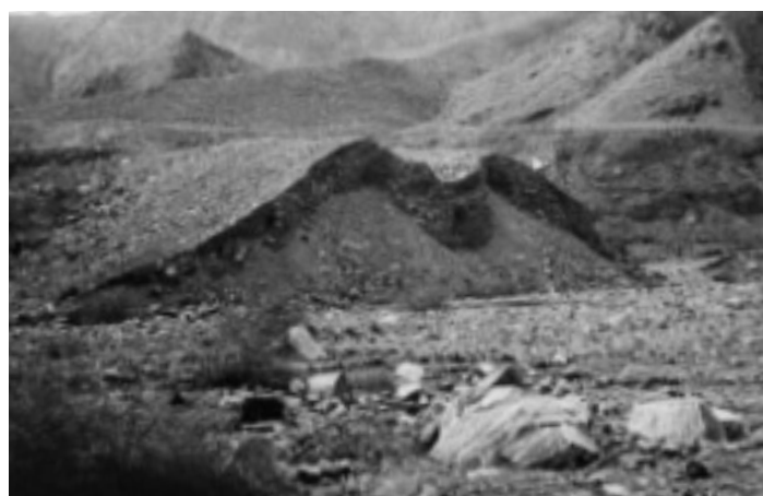
Fig. No. 358.- Acueducto de la acequia de La Cumbre, destruido por las avenidas (Valle de Chicama, Trujillo).
