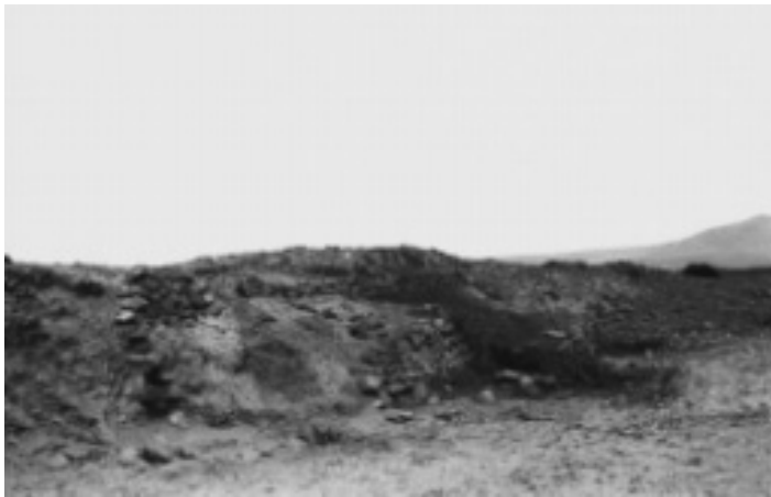
Fig. No. 369.- Los refuerzos típicos de una curva en la acequia de Vichansao (Valle de Santa Catalina, Trujillo).
