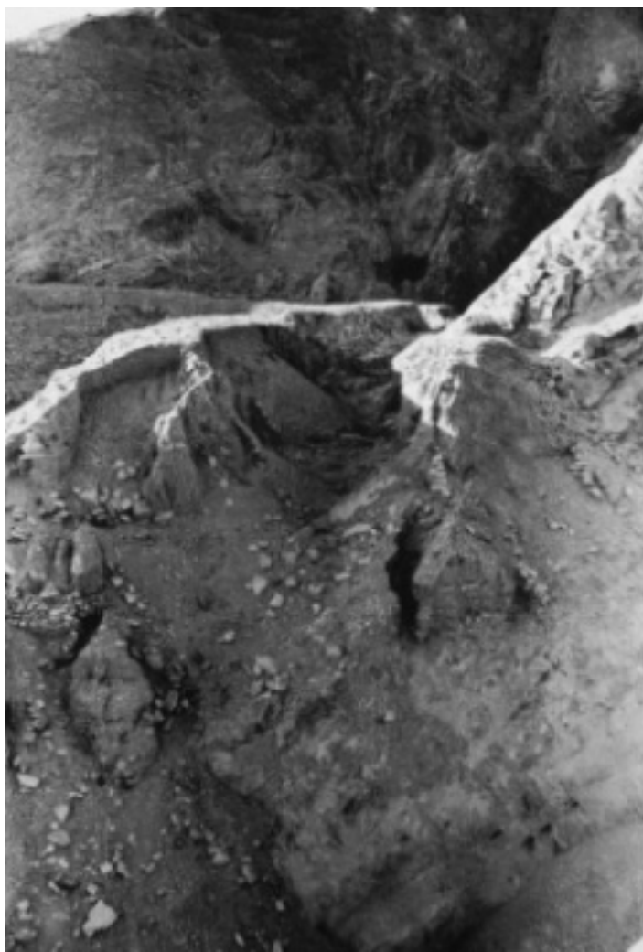
Fig. No. 362.- Vista de uno de los tramos de la acequia de La Cumbre, apoyada en los cerros, en un sitio donde el tiempo ha originado una rotura de consideración.
