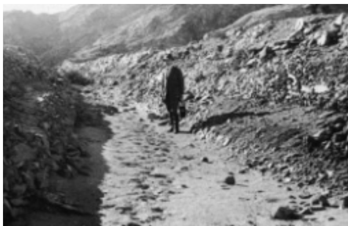
Fig. No. 364.- Tramo bien conservado de la misma acequia que muestra con claridad la sección transversal de doble trapecio.
