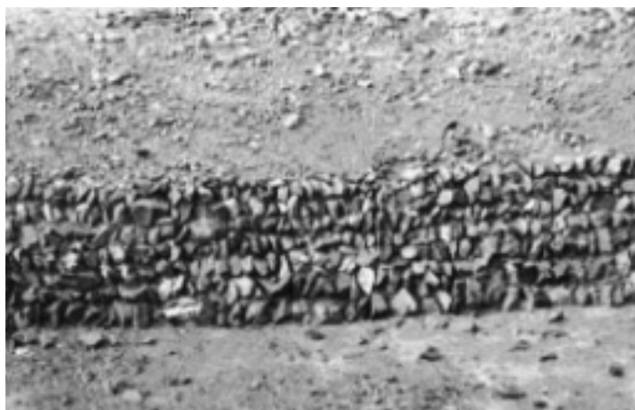
Fig. No. 365.- Importante borde de piedra superpuesto en la acequia de La Cumbre (Valle de Chicama, Trujillo).
