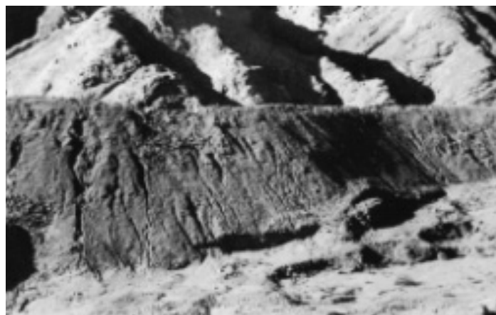
Fig. No. 374.- La base del acueducto mochica formado de tierra aprisionada, traída del valle.
