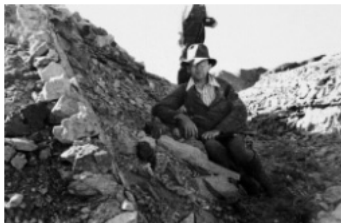
Fig. No. 375.- Muros del canal que se ofrecen en perfecto estado de conservación. En la fotografía puede apreciarse la inclinación que tenían, a la par que su solidez.
