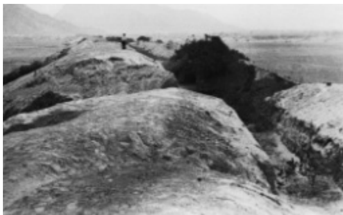
Fig. No. 389.- Acueducto de Ascope: parte superior donde se aprecia la berma por donde discurría el agua de regadío.
