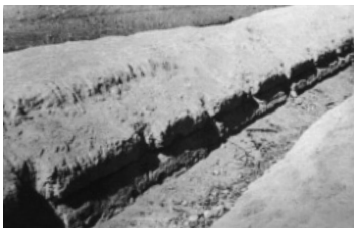
Fig. No. 391.- Detalle del canal del acueducto de Ascope. Nótese en la berma, por la parte inferior, los cortes a manera de estrías que tienden a eliminar el factor erosivo de las corrientes laterales exteriores desviándolas al centro.
