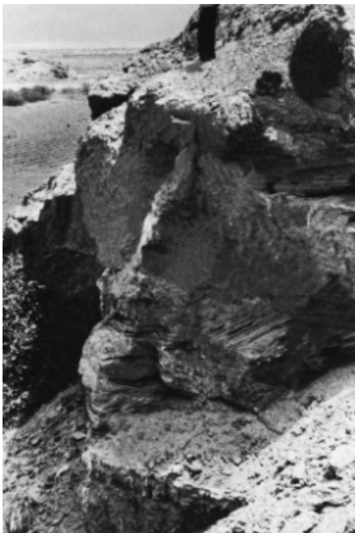
Fig. No. 384.- Acueducto de Ascope: corte producido por la gran acumulación de aguas.
