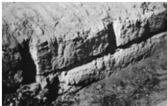
Fig. No. 390.- Detalle de los cortes de las bermas del canal en el acueducto de Ascope (Valle de Chicama, Trujillo).
