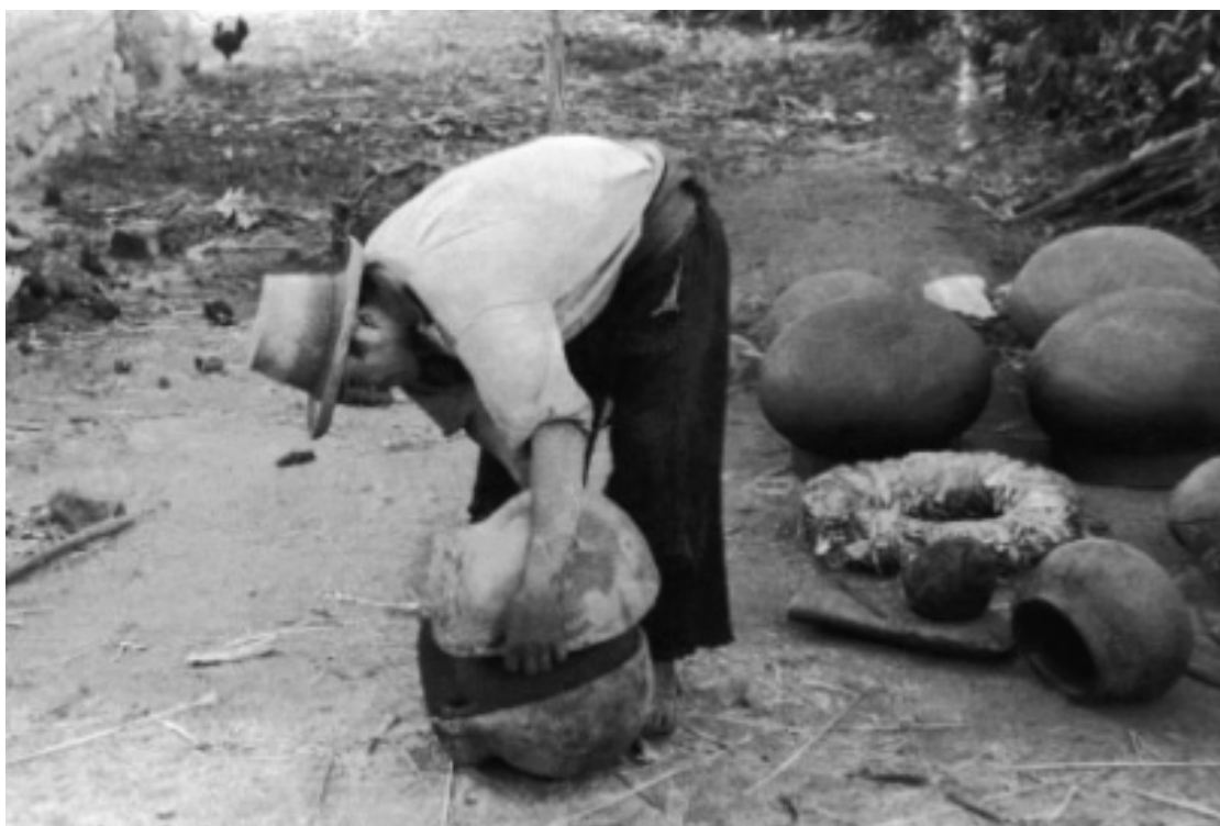
Fig. No. 119.- Alfarería moderna. El alfarero en actitud de sacar los moldes de una olla grande.
