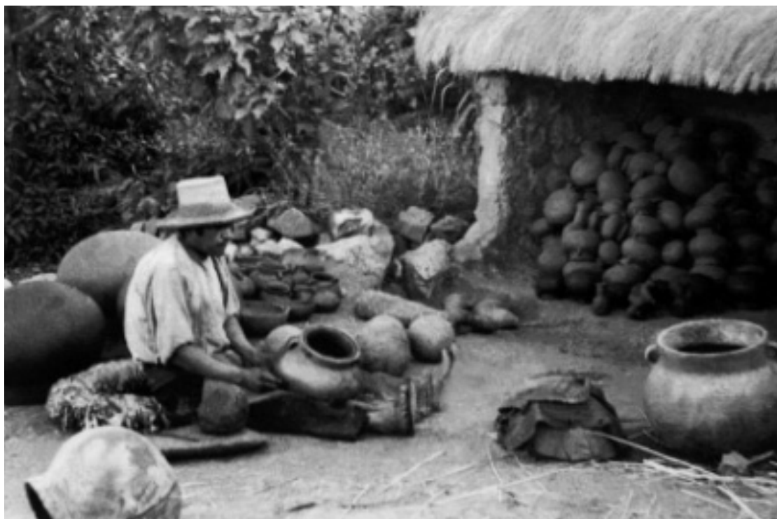
Fig. No. 118.- Alfarería moderna. El alfarero serrano, rodeado de sus objetos, en momentos de dejar adherida ya la arcilla a los moldes.
