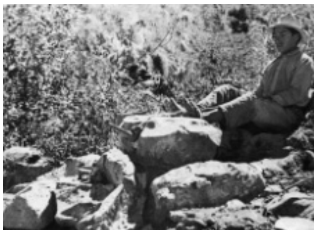
Fig. No. 139.- Tipo de molinete, construido últimamente con su vía de escape para el deslame del mineral. Tulpo, Santiago de Chuco.
