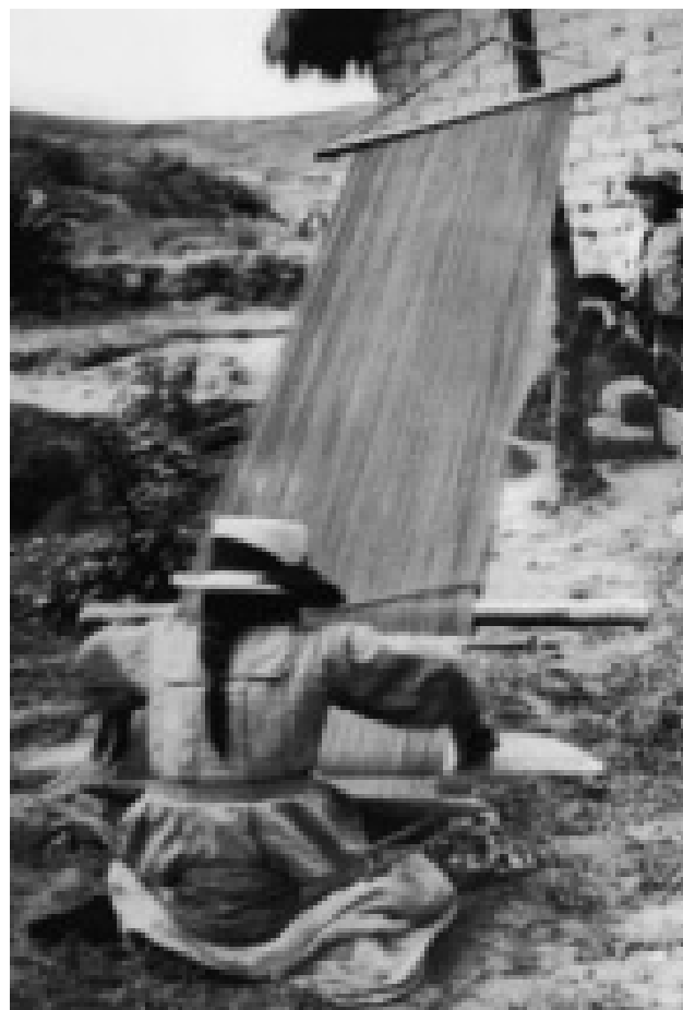
Fig. No. 201.- La misma tejedora utilizando la CALLUA, después de haber pasado el TRAMADOR y roqueado los hilos.
