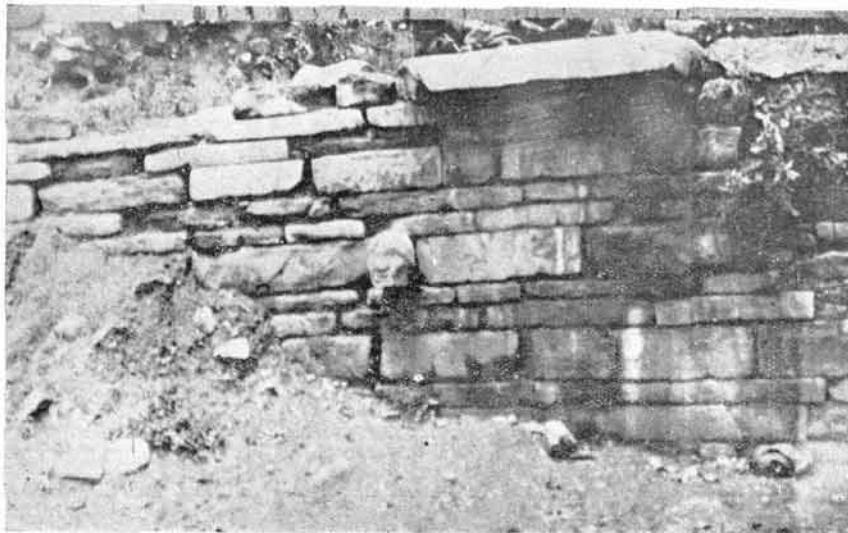
Fig. 5 — Ruinas del Templo de Chavín. Arquitectura lítica de Nepeña
